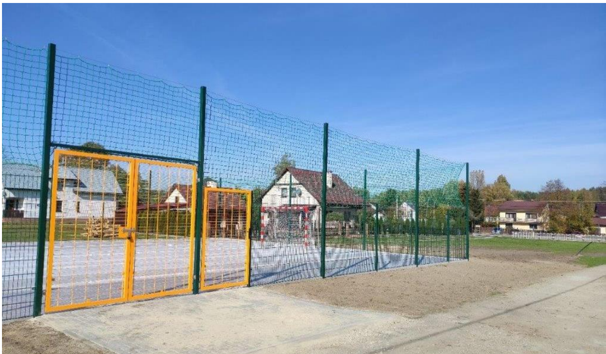
Rys. 27, 28 Boisko przyszkolne w Siedlance
