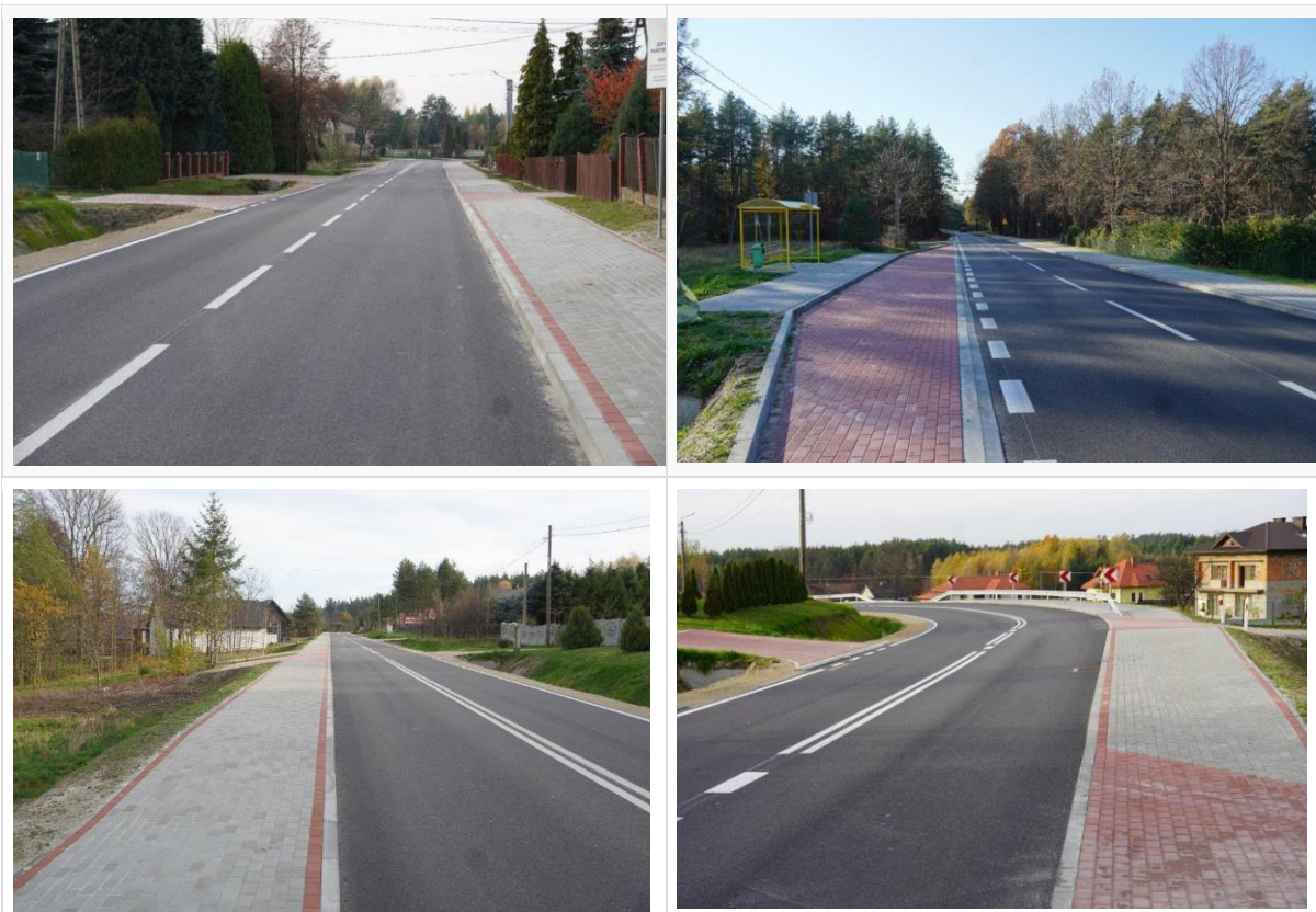
Rys. 9, 10, 11,12 Zmodernizowany na długości 1 128 mb odcinek drogi powiatowej Nr 1 176 R Tuszyna – Niwiska – Kolbuszowa w miejscowości Niwiska
